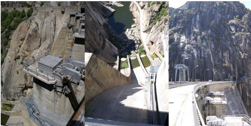
Compuertas y Aliviaderos – Aldeadávila I
